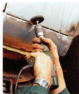
Schweißnahtbearbeitung mit einer Delta Schafrundbürste.
