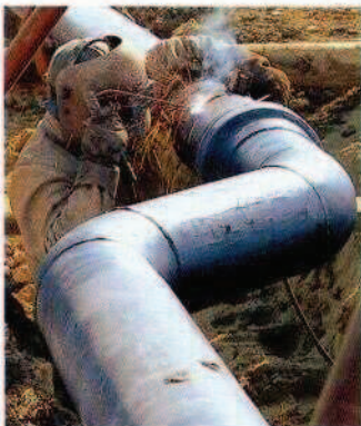
Schweißnaht-Bearbeitung an einer Pipeline mit der gezopften Ultra Einzelscheiben-Bürste.
